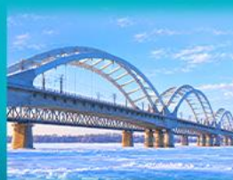
สะพานรถไฟโปนิว
